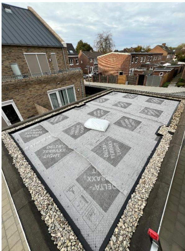
Dak van een berging aan de Askalonstraat tijdens de aanleg van de Dakbloemenweide oktober 2024.
