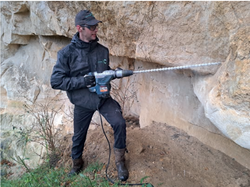
▲ FIGUUR 8 Realiseren van kunstmatige holletjes met een extra lange boor (foto: D. van Hooren).
